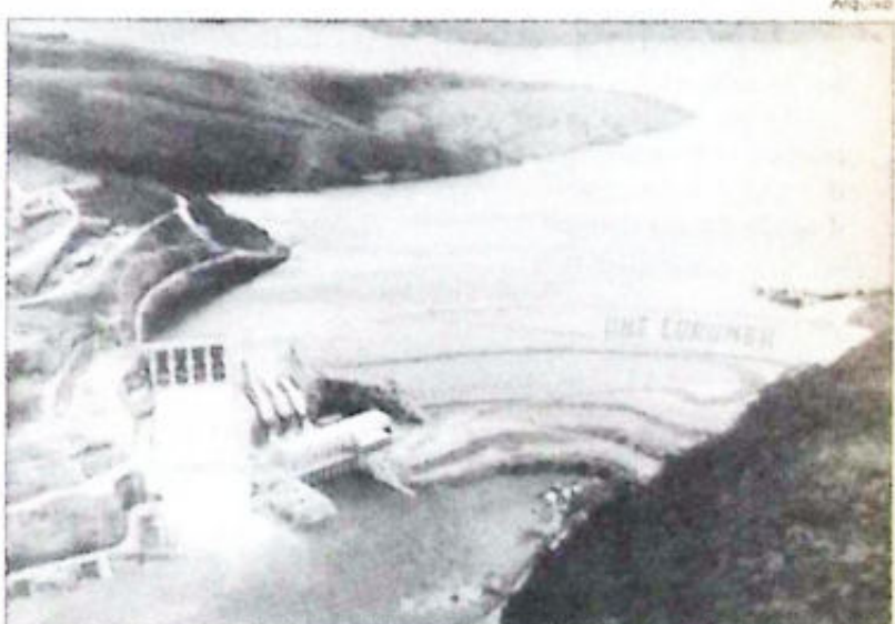
A Usina de Furnas é responsável pela distribuição da energia de Cuiabá I
