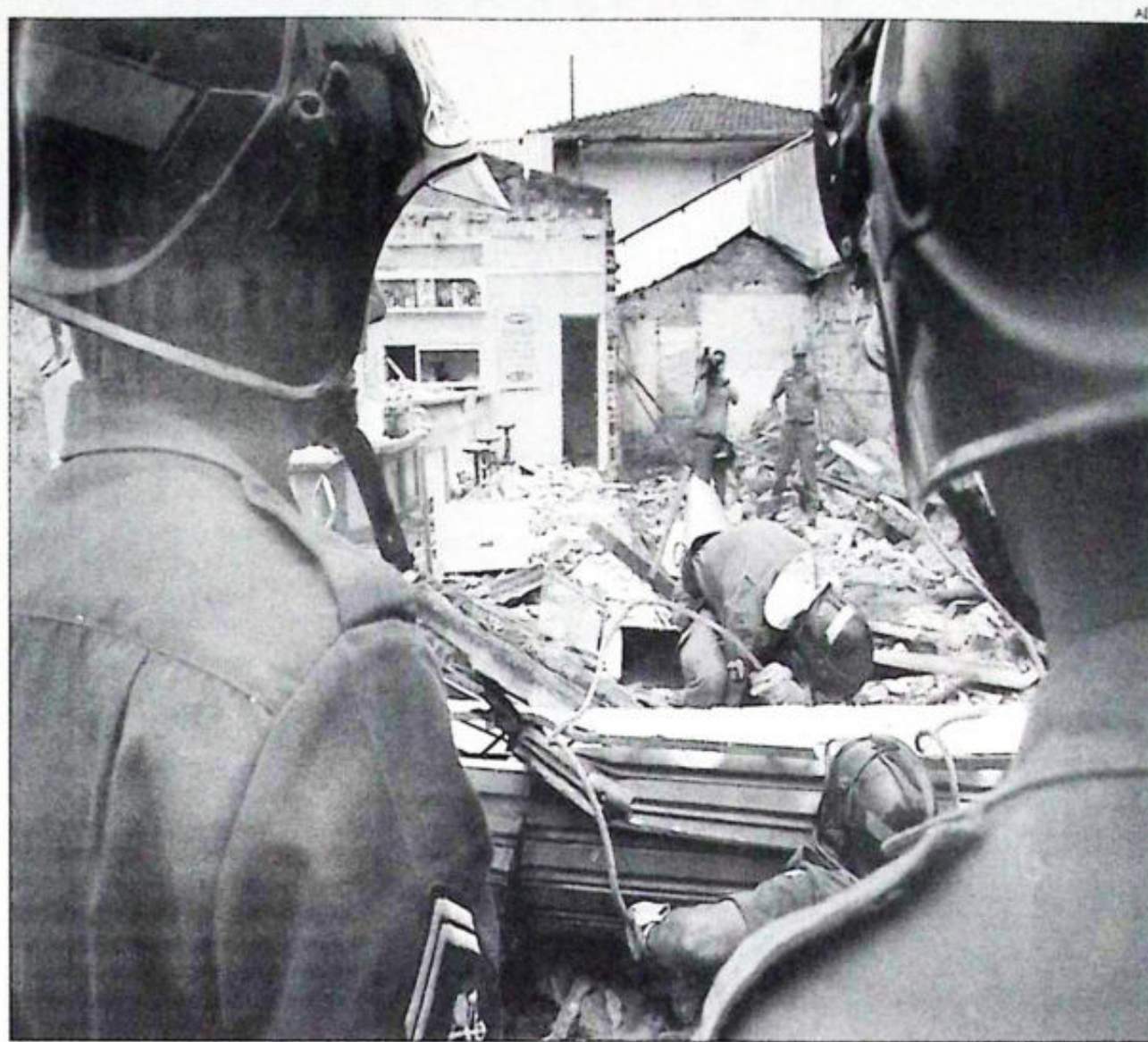
Homens do Corpo de Bombeiros retiram os escombros do bar Las Máscaras, localizado na zona sul de São Paulo
