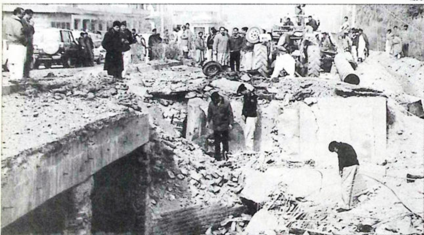
A ponte próxima à casa de Nawaz Sharif explodiu segundos depois dele e sua família terem passado pelo local
