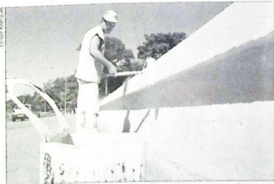
O projeto do Dermo/Compav vai dar mais beleza às pontes que cobrem a via
