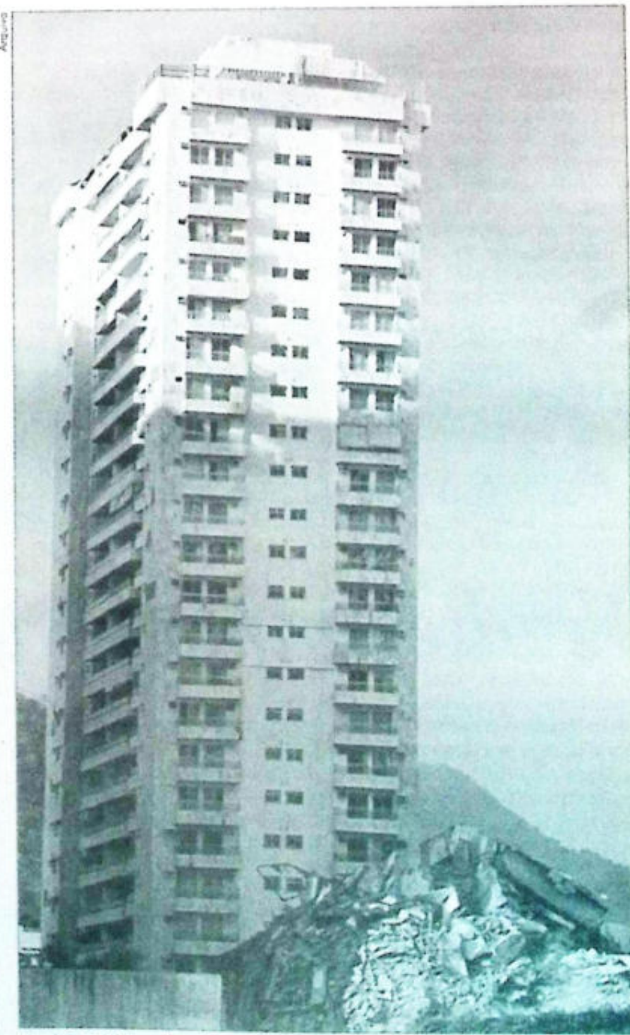
O edifício Palace I está interditado e corre o risco de também desabar
