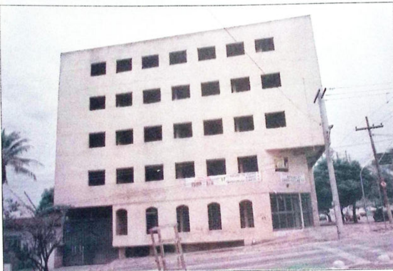
Construção na Avenida Assis Chateaubriand com a República do Líbano foi embargada pela Prefeitura de Goiânia
