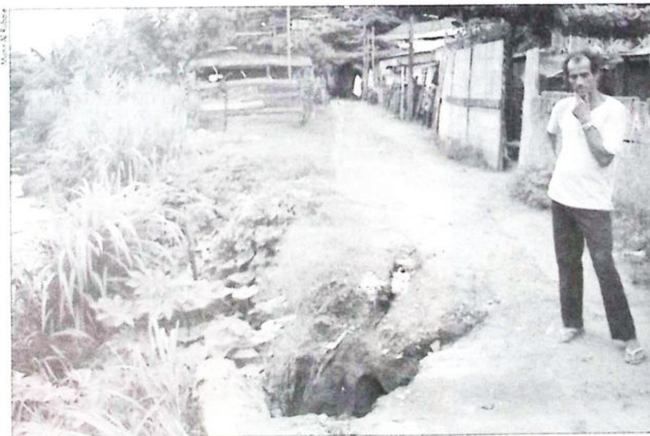
Morador mostra erosão às margens do Córrego Anicuns. A Comob quer retirar todos os habitantes das áreas perigosas
