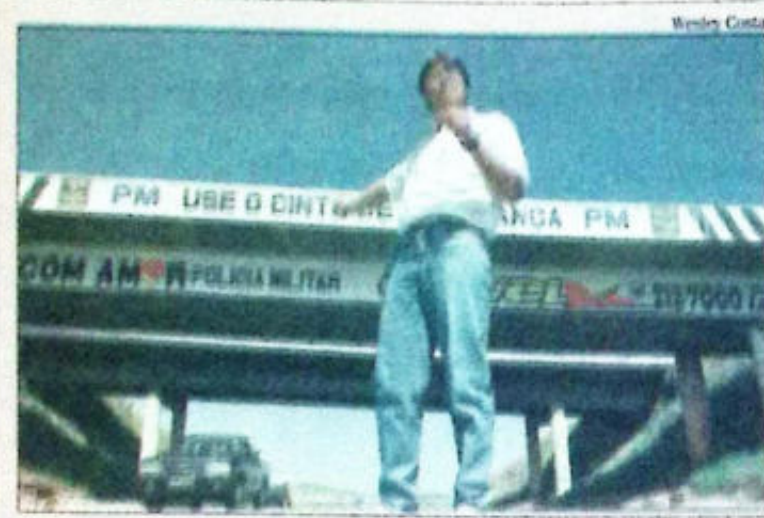
Argemiro: pilares estão sendo "comidos" pela ferrugem
