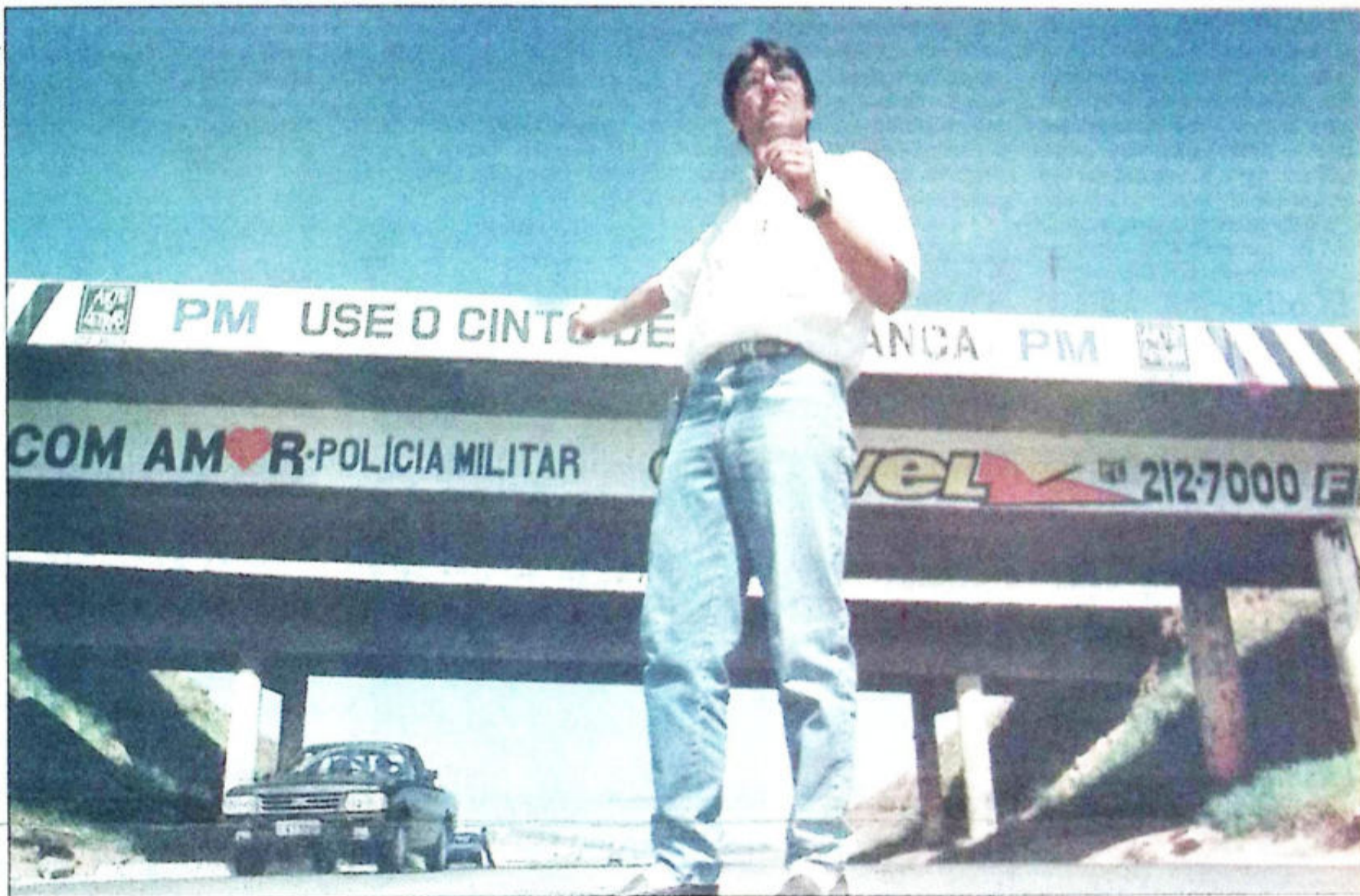
Argemiro Mendonça, especialista em estruturas, garante que o viaduto da BR-153, próximo ao Carrefour, está condenado e pode desabar a qualquer momento
