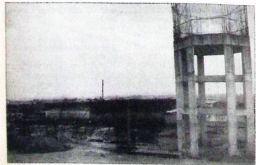
As obras da Estação de Tratamento de Água de Luziânia estão adiantadas
