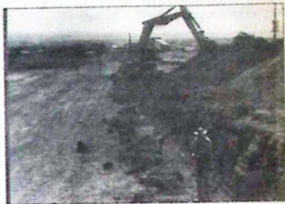
Máquinas e homens já trabalham no local
