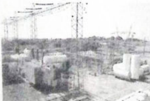
Subestação Goiânia-Leste (ampliação) Instalação de um transformador 230/13,8 KV, 34 mil KVA de potência
