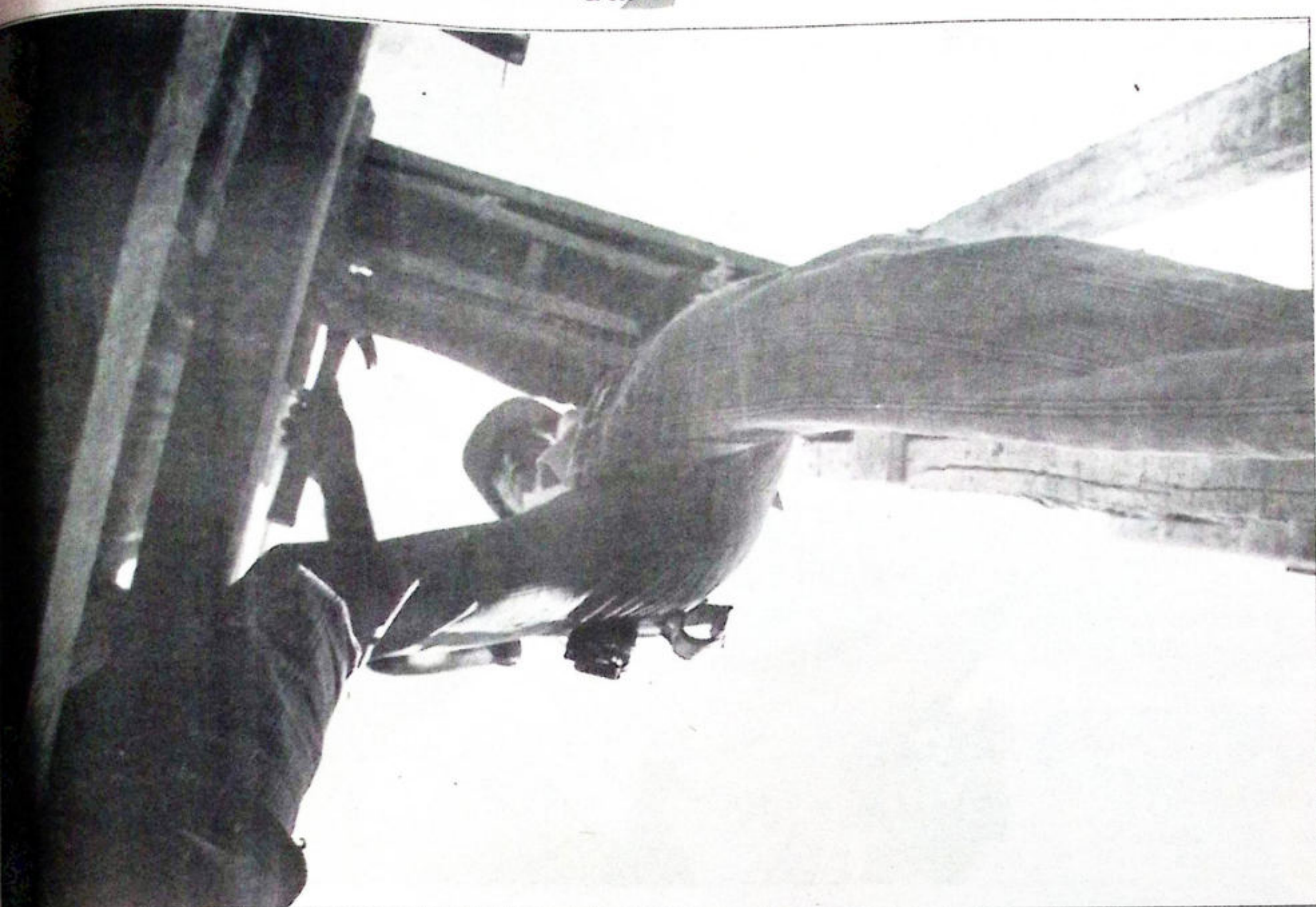
Dependurado no ar ou se arrastando pelas vigas, o pedreiro segue com a obra
