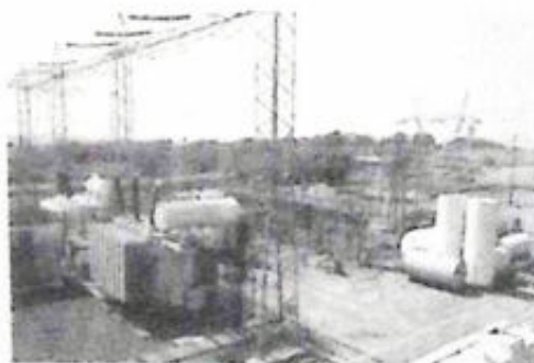
Subestação Goiânia-Leste (ampliação) Instalação de um transformador 230/13,8 KV, 36 mil KVA de potência
