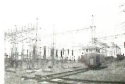
Subestação Anhanguera (ampliação) Instalação de um transformador 138/69 KV, 25 mil KVA de potência
