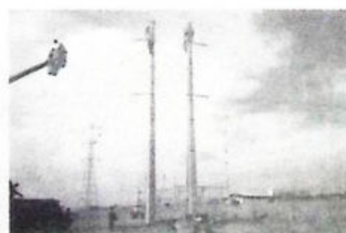
Subestação Goya Implantação de subestação 138/13,8 KV, 33,25 mil KVA de potência
