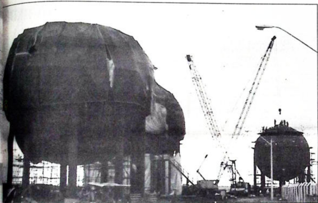
As esferas que vão armazenar gás de cozinha estão em ritmo adiantado
