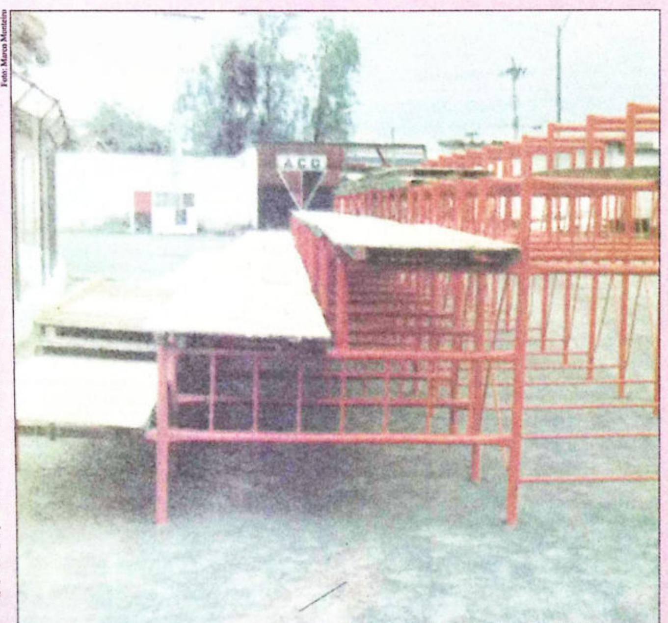
Ontem começou as instalações de arquibancadas móveis no Estádio Antônio Accioly para o jogo de amanhã
