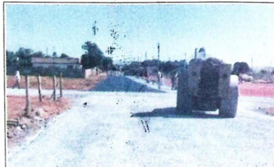
Vários trechos de ruas e avenidas foram pavimentados em Itaberaí
