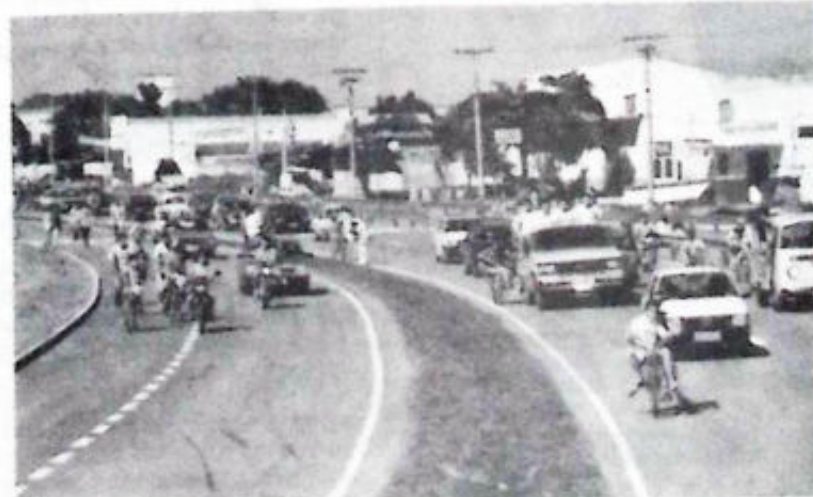
Dois etapas da duplicação da Perimetral Norte já foram concluídas.
