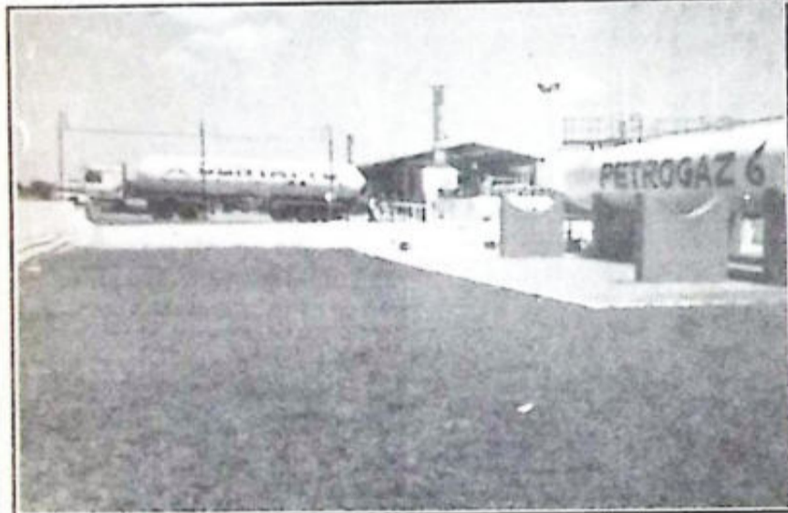
Os sprinklers resfriam os caminhões no momento de descarregamento do GLP - Gás Liquefeito de Petróleo
