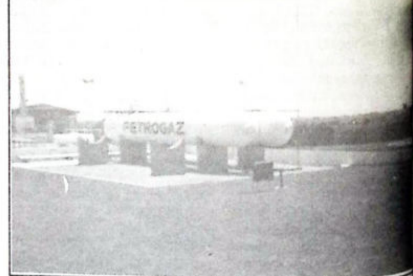
Todo gás (GLP) está estocado nos tanques, a uma distância segura das moradias da vizinhança
