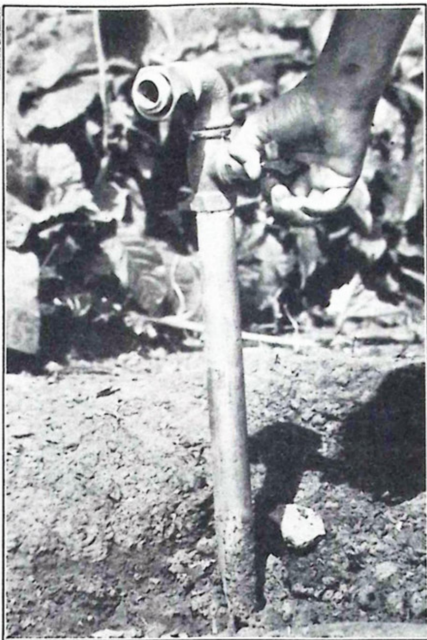
Os canos ficaram expostos, desconectados do aparelho medidor
