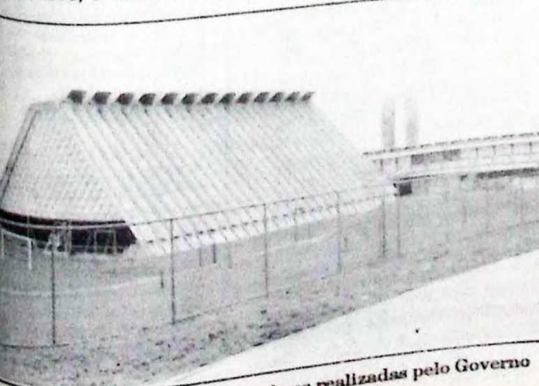
Os Ciacs do DF somam-se às obras realizadas pelo Governo
