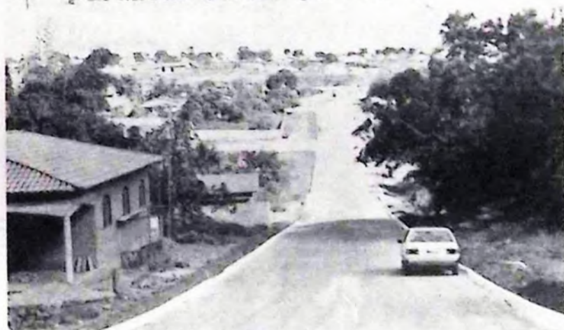
A Prefeitura fez 20 mil metros quadrados de asfalto no setor São Geraldo
