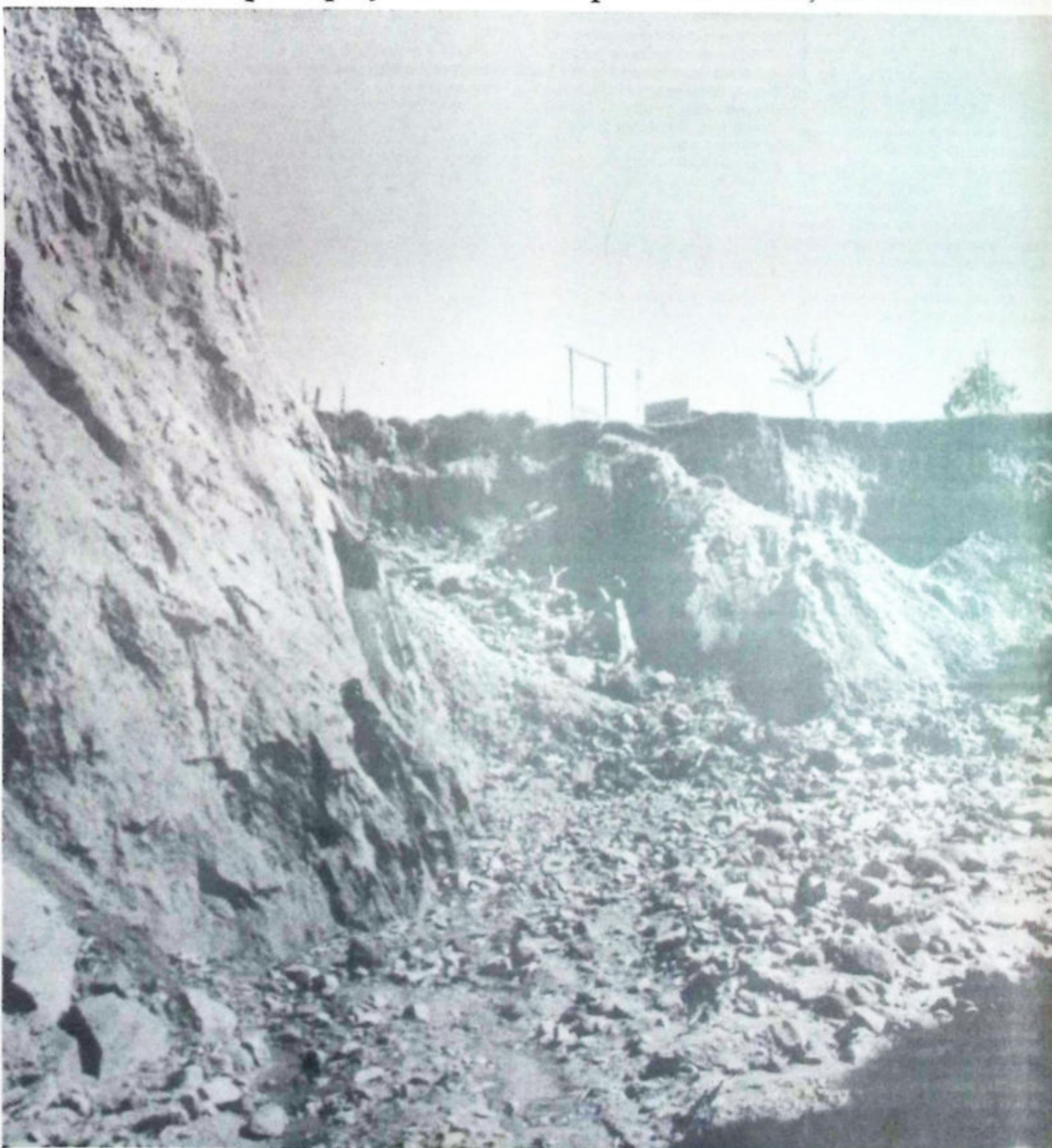
A gigantesca erosão já atingiu a casa da chácara, tanques de criação de peixes ornamentais, chalé e piscinas
