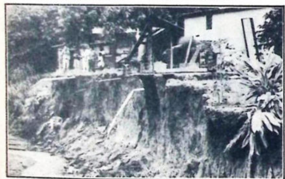
As erosões às margens do córrego Palmito ameaçam até as casas.
