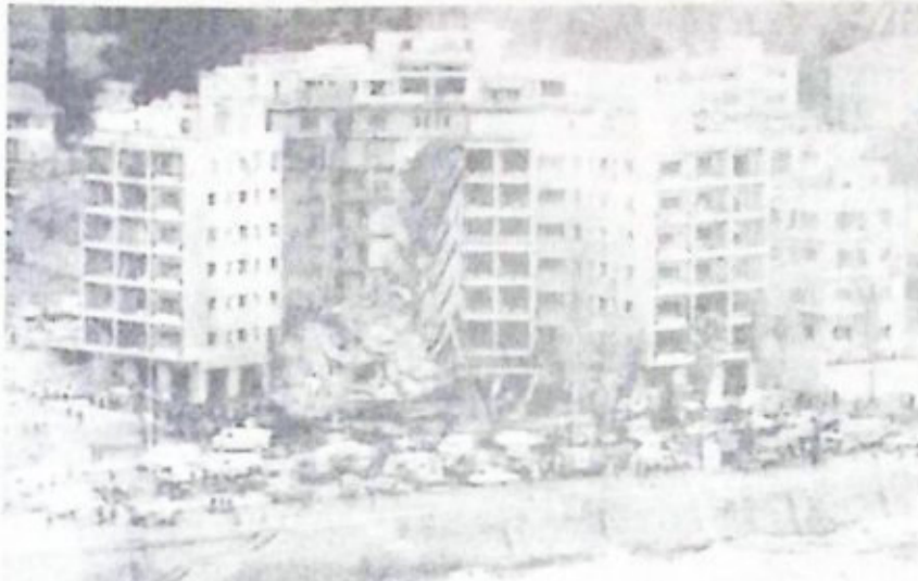
Esta foto, tomada de um helicóptero, mostra os danos causados pela bomba
